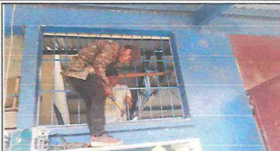
Foto 2: Se observa el mantenimiento de las ventanas.
