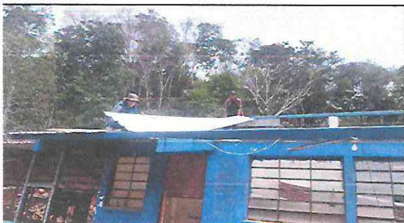
Foto 3: Se observa el cambio de techo del aula.
