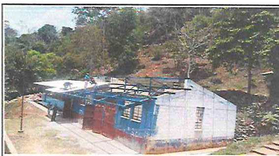
Foto 4: Se observa el cambio completo del techo de la escuela.
