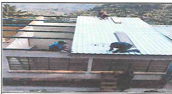
Foto 5: Se observa un 50% del cambio del techado.
