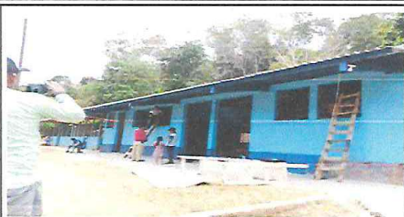
Foto 1: Se observa el mantenimiento de las puertas.
